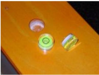
Damit der klapp- und transportierbare Tisch am Aufbauort waagrecht ausgerichtet werden kann, soll im Torkastendeckel auf jeder Seite eine kleine Dosenlibelle versenkt werden. Das Bild zeigt eines der Löcher im bereits fertig lackierten Torkastendeckel. Montiert werden die Libellen im fertigen Tisch, der mit einer normalen Wasserwaage ausgerichtet wird. Dann sollen die Libellen mit einem spaltfüllenden Knetmassenartigen Kleber so eingesetzt werden, dass auch sie sich in Waage befinden.
